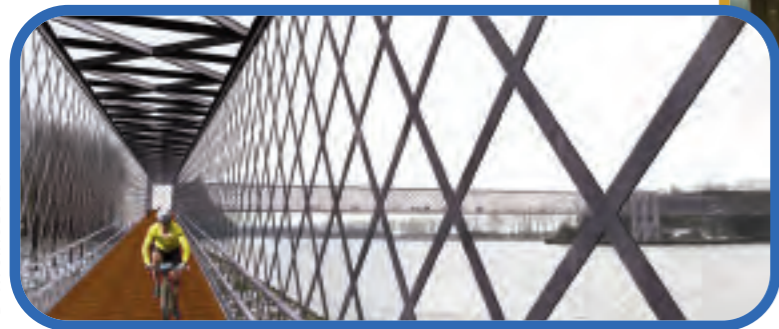
Baileybrug bij de Plofsluis, Nieuwegein
